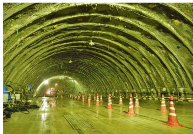
写真-4 減水対策施工後の状況
