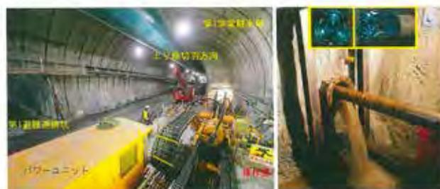
・削孔には特殊なビットを使います。ビットは超高水圧で回転させます。
